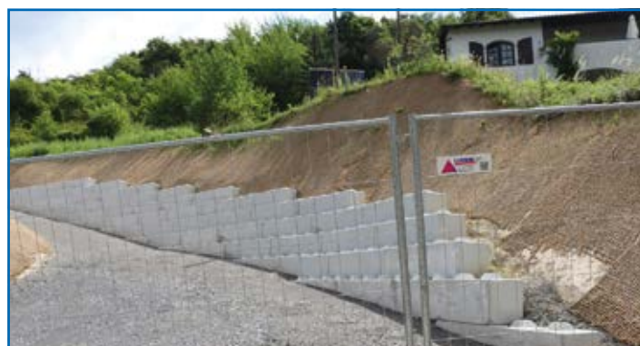
Die Stützsteine dienen vorübergehend zur Sicherung der Böschung
